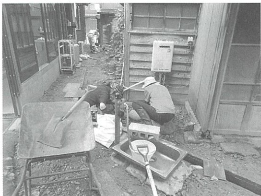
家周りの泥撤去作業
