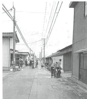
路肩排水溝の泥出し
