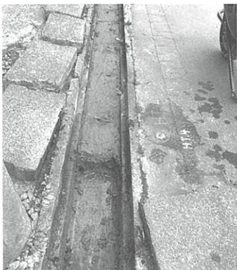
路肩排水溝の状況
